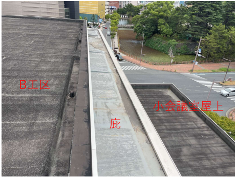
B工区 庇 小会議室屋上
