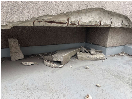
爆裂部 浮き部撤去 鉄筋保護 モルタル補修不要
