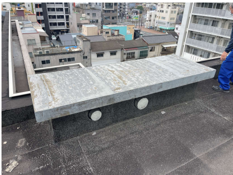
ハト小屋天端 ウレタン塗膜塗り
