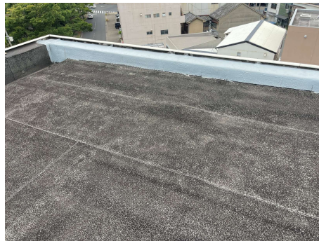
A工区 B工区 既設防水浮き部 浮き部15箇所程度有 カットの上増し張り
