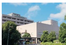
東京都世田谷区 関東中央病院
